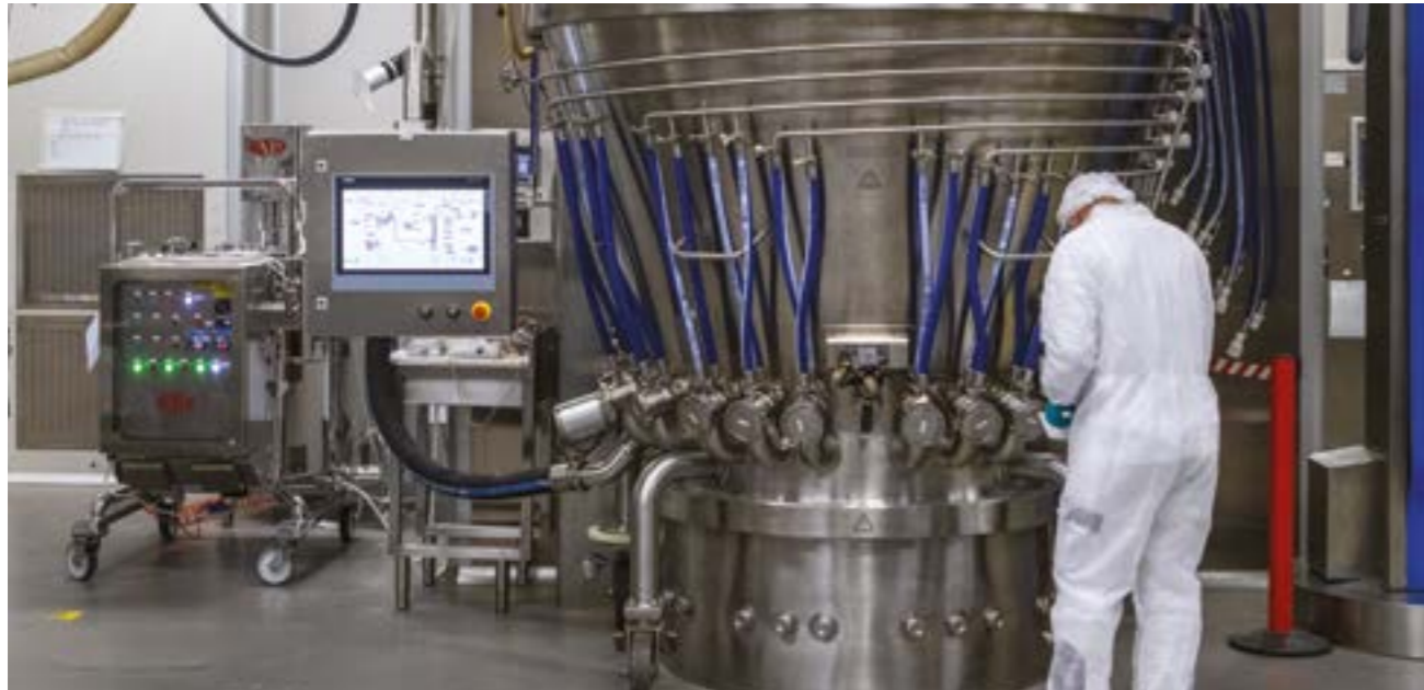
Nel reparto di preparazione solidi dello stabilimento di Ancona
